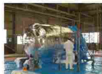
図12: 積層真空断熱材の施工状況
